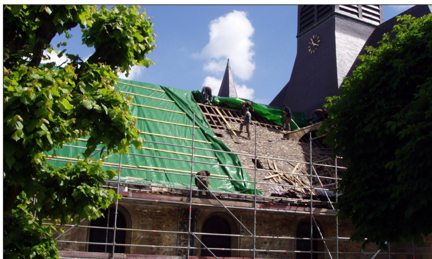
Une entreprise chaumontaise renouvelle la toiture de la nef.
